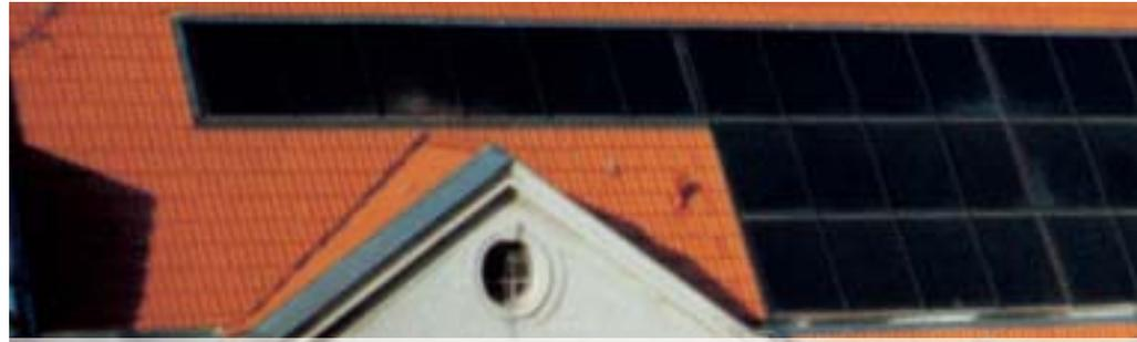
Für die Bestimmung der notwendigen Kollektorfläche ist es zunächst erforderlich, den Energiebedarf  $E_{BW}$  zur Erwärmung des Brauchwassers zu bestimmen. Er errechnet sich aus dem Produkt des täglichen Warmwasserverbrauchs  $V$ , der Anzahl der Verbrauchstage  $d$  und der Energiemenge  $Q$ , die zur Erwärmung eines Liters Wasser auf ein gewünschtes Temperaturniveau notwendig ist:
