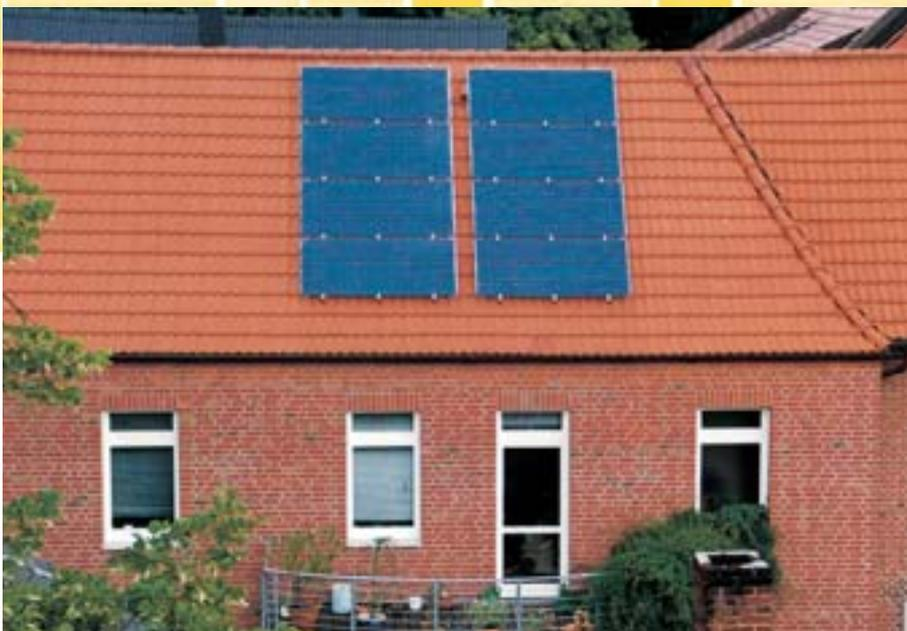
Abb. 48: Photovoltaikanlage in Greven (Leistung 2 kW<sub>p</sub>)
