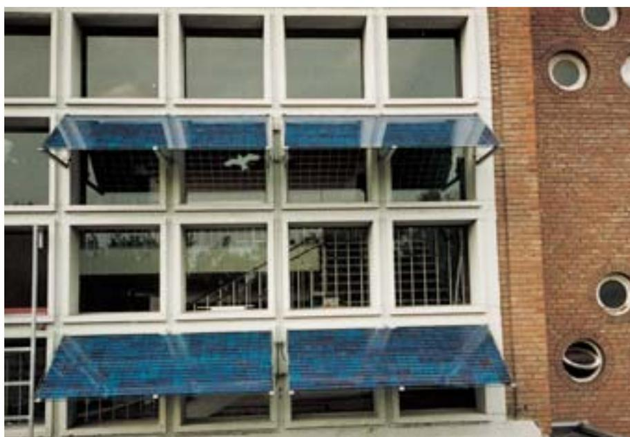
**Abb. 47: Aufgeständerte Photovoltaikanlage an einer Schulfassade in Düren (Leistung: 1 kW<sub>p</sub>)**
