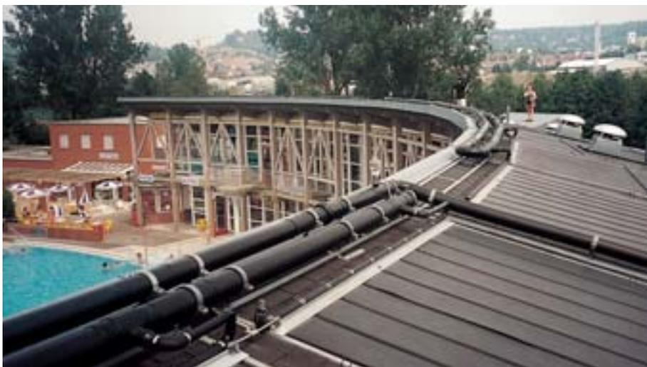
**Abb. 39: Beispiel einer solaren Schwimmbadwassererwärmung**
